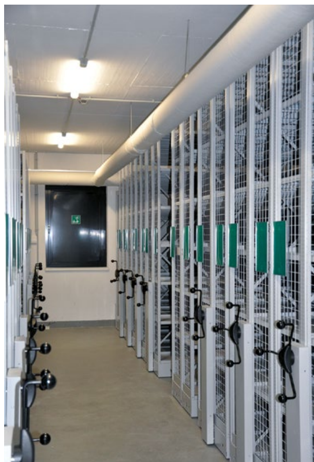
Eines der Fenster zu Entrauchung, die zugleich als zweiter Rettungsweg dienen. An der Decke der Textilschlauch für die Belüftung. (Quelle: LWL-Archivamt)
