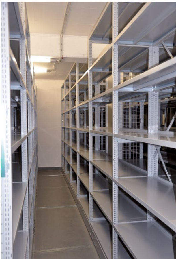
Absenkung der Regalhöhe unter den Unterzügen (Foto: LWL-Archivamt)
