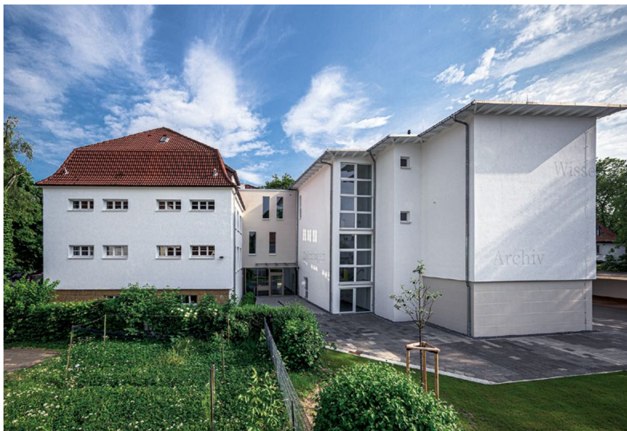
Seitenansicht des neuen Stadt- und Kreisarchivs Gütersloh (Foto: Detlef Güthenke)
