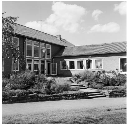
Gebäude der Landeshauptmann-Salzmänn-Schule (höhere Fachschule für Sozialarbeit), 1959 fertiggestellt (Quelle: Karl Franz Klose, ©LWL-Medienzentrum für Westfalen)
