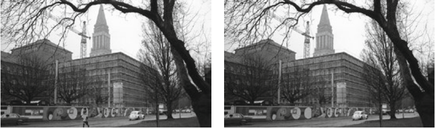
Abb. 5 und 6: Neubau des Westflügels des Kieler Opernhauses 1971 (StadtAKiel 31020, 2.3 Friedrich Magnussen, original und retuschiert): Die retuschierte Version zeigt, dass das Hauptbildmotiv das Opernhaus ist. Die Frau, die ins Bild läuft, gilt als Beiwerk.
