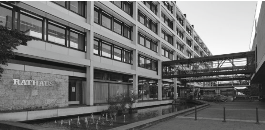
Abb. 2: Diensträume und Magazine des Stadtarchivs sind in dem zwischen 1962 und 1966 errichteten und seit 2013 denkmalgeschützten Reutlinger Rathaus untergebracht. (Stadt Reutlingen, Amt für Presse und Öffentlichkeitsarbeit)
